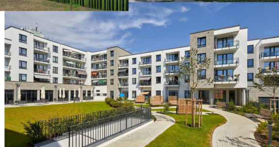
Bildquelle: Adlershorst Baugenossenschaft eG, Paloh Architekten
